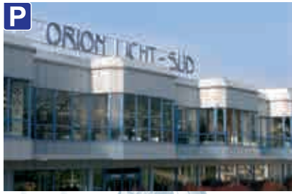
ORION Licht Wien - Süd 1230 Wien, Oberlaaer Straße 281-283 Tel.: 01/616 68 30, Fax: 01/616 71 45
